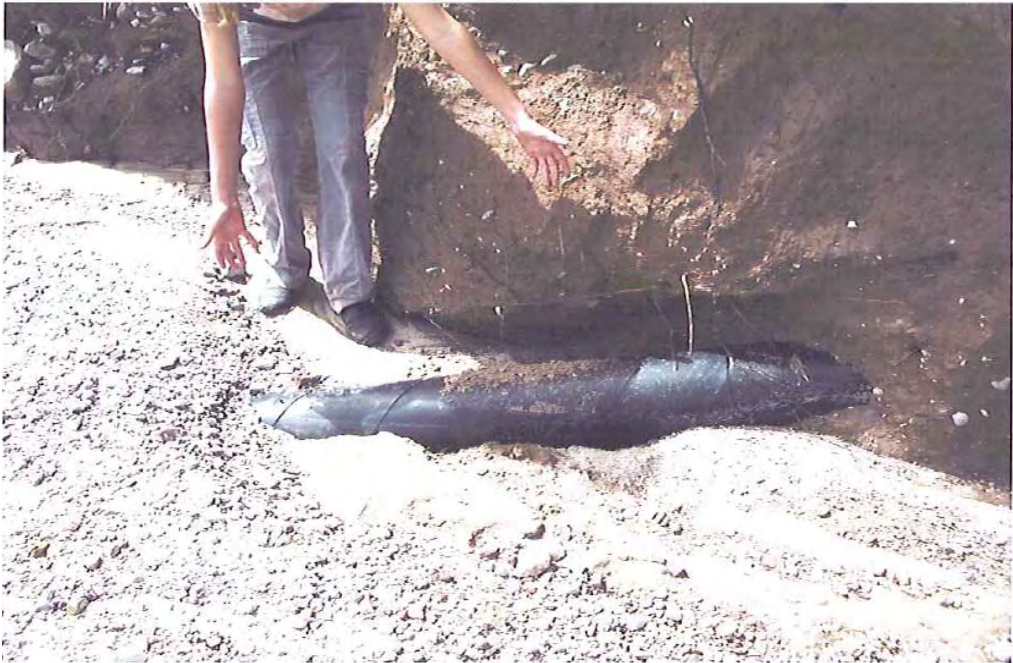
Exposed pipelines on Las Huertas Creek
